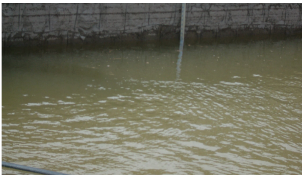
نگاره شماره ۱- اندازه گیری نفوذ آب در مخزن سازه
