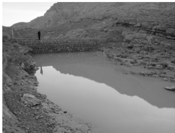
شکل ۵- بند سنگ و ملاتی (رسوبگیر) باغ سلیمه
