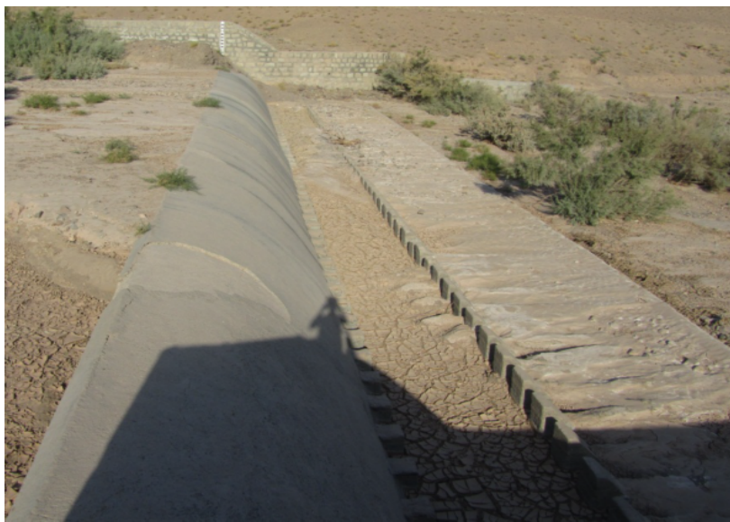
شکل ۲. رسوبگذاری شدید و عدم رعایت طول صحیح حوضچه‌ی آرامش
