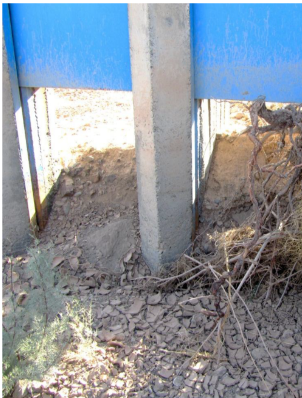
شکل ۱. رعایت نکردن انحنای دیواره و زبری صحیح
