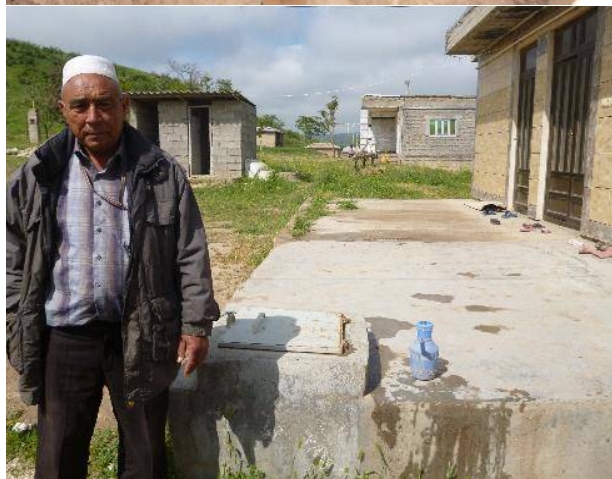
شکل 2 روستای آق چاتال و سامانه های استحصال آب باران تصاویر سمت راست نشان دهنده تانکرهای فلزی استحصال آب باران برای دامداری و دو تصویر سمت چپ به ترتیب حفاری مخزن استوانه ای شکل (بالا) و مخزن آب باران است که به عنوان ایوان منزل استفاده می شود.
