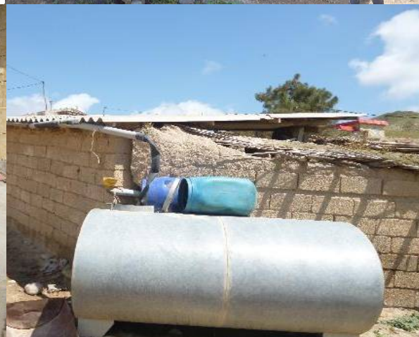
شکل 2 روستای آق چاتال و سامانه های استحصال آب باران تصاویر سمت راست نشان دهنده تانکرهای فلزی استحصال آب باران برای دامداری و دو تصویر سمت چپ به ترتیب حفاری مخزن استوانه ای شکل (بالا) و مخزن آب باران است که به عنوان ایوان منزل استفاده می شود.
