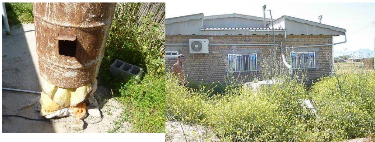
شکل 4 سیستم استحصال آب باران در روستای یلی بدراق - نمونه‌ای از آب بسیار شفاف باران، اتصالات هدایت آب از سقف به درون مخزن و نحوه محافظت از دینام از سرمای زمستان
