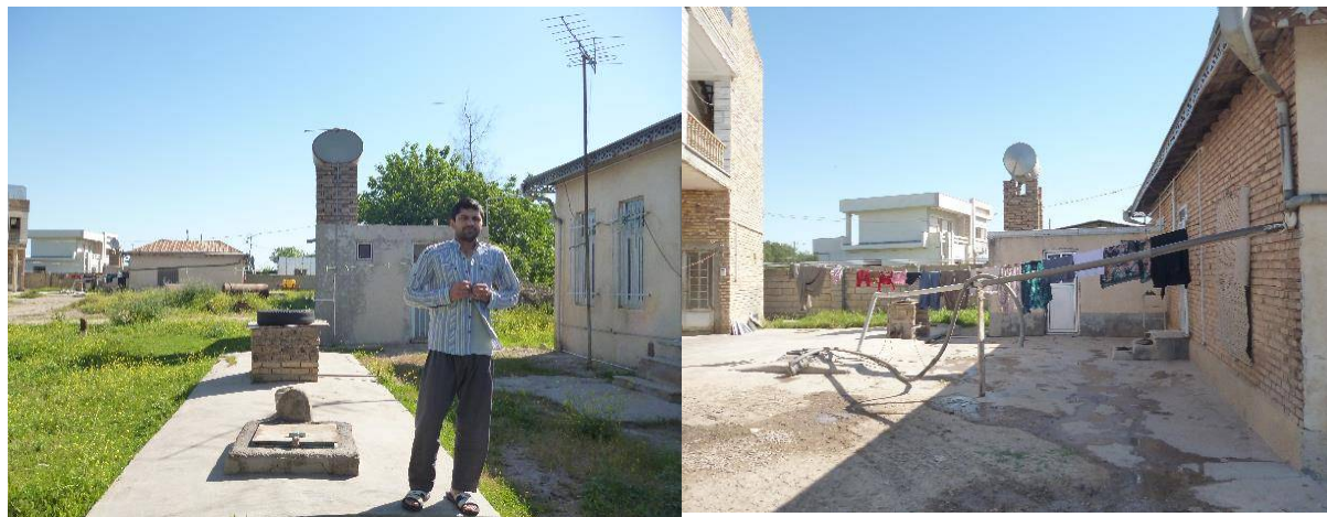
شکل 3 نمایی از سامانه های استحصال آب باران در روستای تمر قره قوزی - به نحوه قرارگیری تانکر موقت ذخیره آب بر روی دیوار کوتاهی که برای این منظور ساخته شده دقت کنید.
