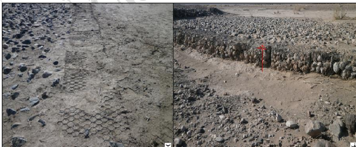
شکل (۳): محل سر ریز پشته خاکی. الف: قبل از رسوبگیری. ب: بعد از رسوبگیری.
