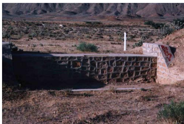
شکل ۵- دروازه قائم پخش سیلاب گربایگان
