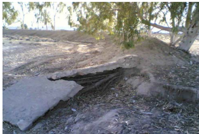
شکل ۷- تخریب دروازه به علت وجود ریشه درختان
