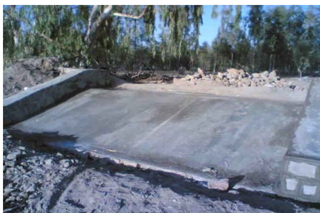
شکل ۴- دروازه مایل تیپ ۲ پخش سیلاب گربایگان
