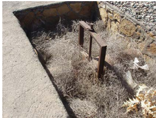
شکل ۹: وضعیت نمونه‌ای از شیرهای تخلیه تحتانی بلااستفاده در پروژه‌ها
