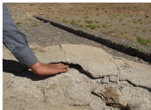
شکل ۷: استفاده از مصالح نامناسب در تهیه بتن
