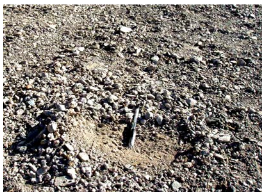
شکل ۸: وضعیت بتن هوازده در سرریز سد خاکی چشمه ایوب فریمان
