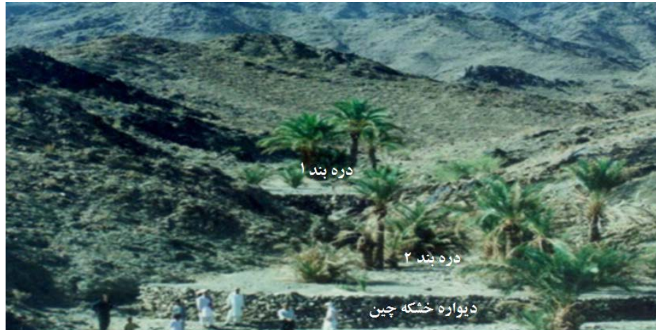
شکل ۵- دربند مرکب کوهستانی و اجزاء آن
