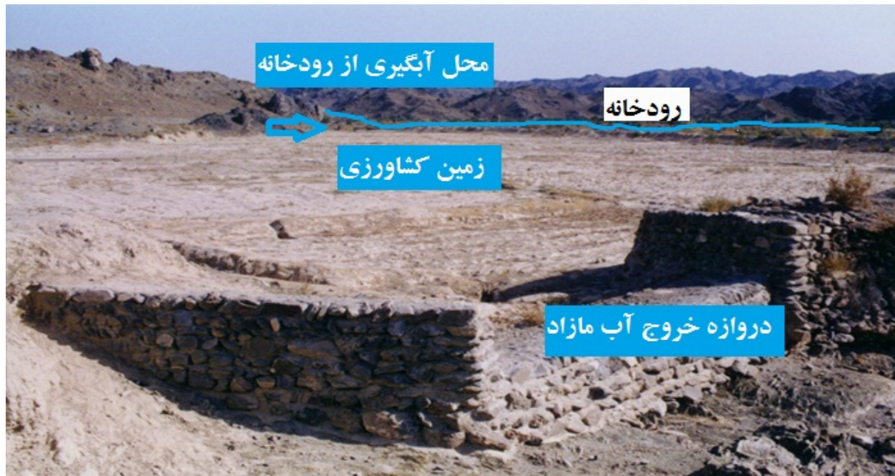
شکل ۲ - اجزاء خوشاب حاشیه رودخانه
