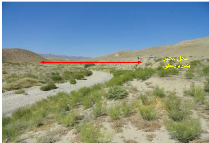
شکل (۶) - تصویری از محل پیشنهادی برای احداث بند زیرزمینی در نقطه Sa-2
