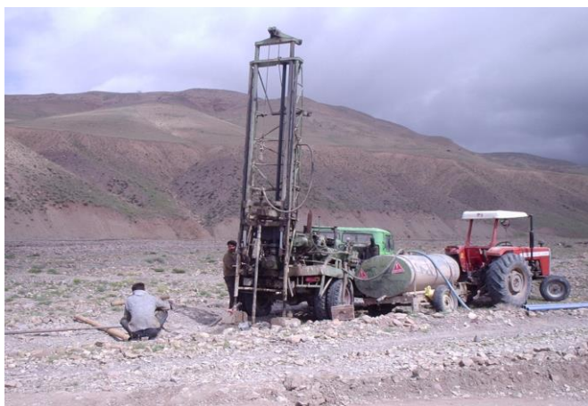
شکل ۶- حفاری چاه های ژئوتکنیکی در محور سد
