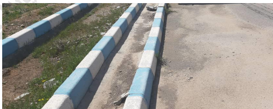
شکل ۴- نمونه کانیو اجرا شده در حاشیه بلوار های اصلی محدوده طرح
