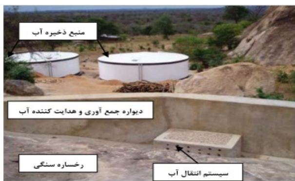
شکل ۳- سیستم جمع‌آوری آب از سطوح صخره‌ای (بهزادفر، ۱۳۹۱)
