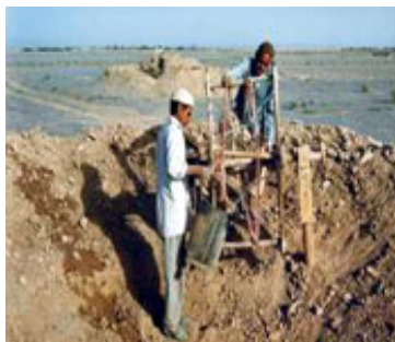
شکل ۷-چرخ چاه در احداث قنات
