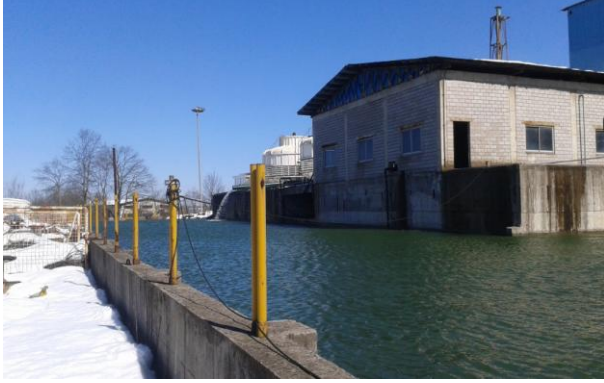
شکل 3: استخر خاکی جمع‌آوری رواناب سطحی (راست)، استخر بتنی ذخیره آب که در مسیر بازچرخانی قرار دارد (چپ)
