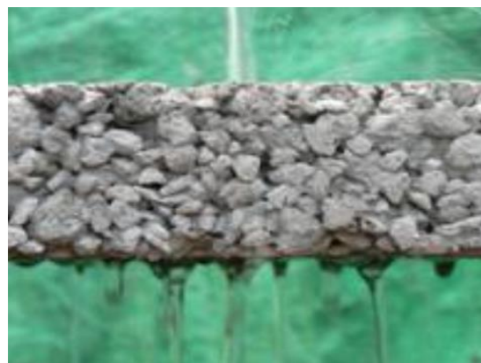
شکل (3) بتن متخلخل
