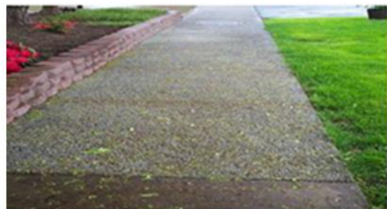
شکل (1) تکنولوژی بتن متخلخل و کاربرد آن در معابر شهری در راستای توسعه پایدار
