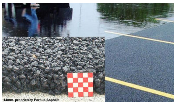
شکل (4) مشخصات و نمونه کاربرد آسفالت متخلخل در مناطق
