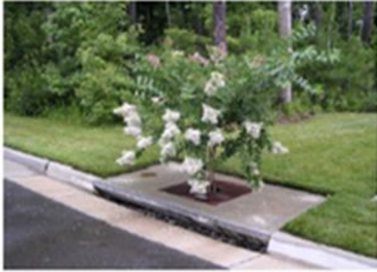
شکل (2) آبیاری فضای سبز و مدیریت منابع آب با تکنولوژی بتن متخلخل
