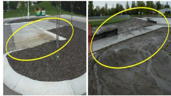
شکل (6) روان آب ایجاد شده بر روی سنگ فرش معمولی و عدم تشکیل روان آب بر روی سنگفرش متخلخل
