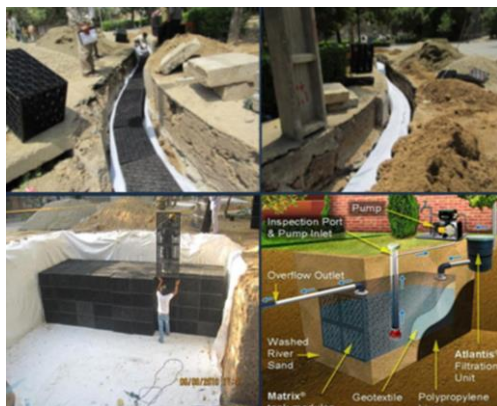
شکل (1) اجرای کانال‌ها و مخازن اکولوژیک در شهرک سجادیه تهران
