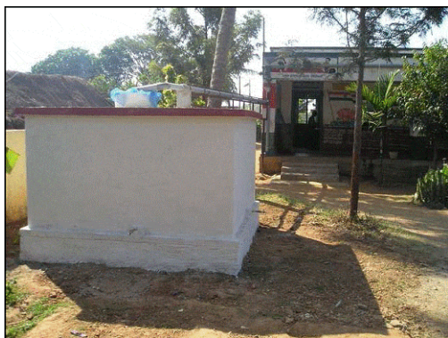
شکل (۱۳) یک مخزن ذخیره ساخته‌شده با مصالح ساختمانی
