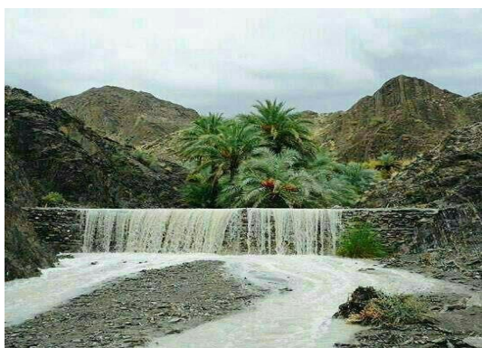
شکل (2) نمایی از یک سازه بومی دربند بعد از بارندگی و سرریز شدن سیلاب در منطقه بشاگرد
