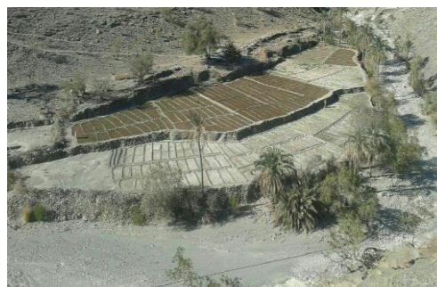
شکل (8) نمایی از کش بندهای ایجاد شده در حاشیه آبراهه
