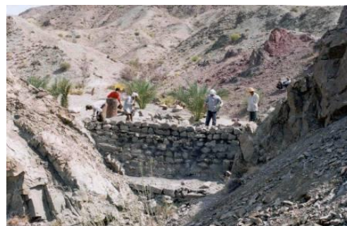
شکل (3) افزودن ارتفاع سازه بعد از کاشت گیاه نیز انجام می شود
