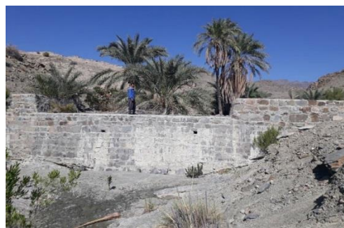
شکل (9) سازه احداث شده دربند و آثار زه آب موجود در پایین دست سازه
