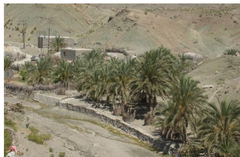
شکل (7) نمایی از کش بندهای ایجاد شده در حاشیه آبراهه
