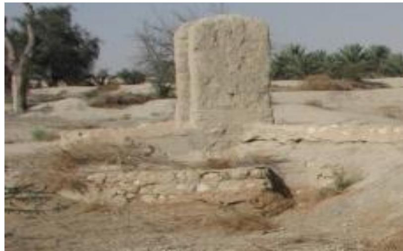
شکل ۴- دریچه تغذیه چاه که در گوشه بند (استخر تغذیه) قرار گرفته و جوانب آن توسط دیواره سنگ و ساروج محافظت شده است.
