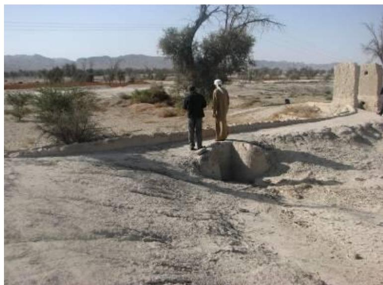
شکل ۵- دریچه کنترل بین بنداب و چاه تغذیه ای مجاور آن بر روی پشتہ خاکی بند
