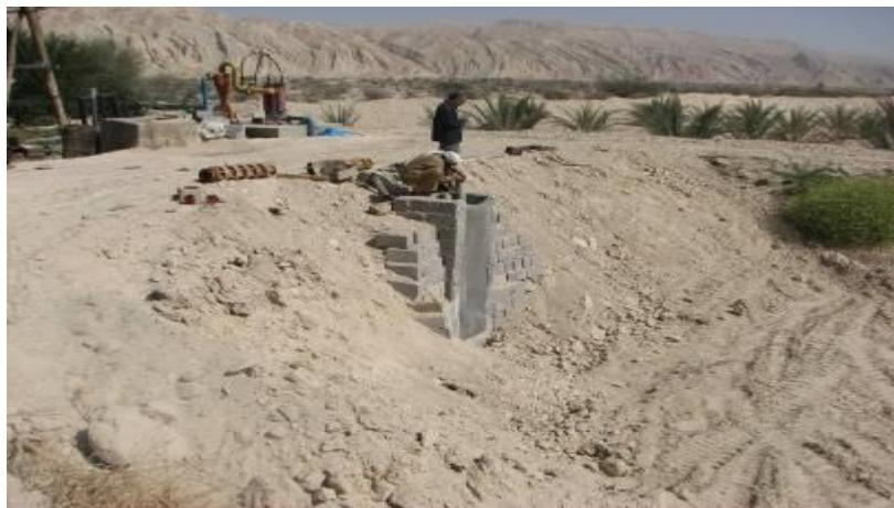
شکل ۱۵- نمایی از دریچه ورودی آب به چاه، همراه با لوله‌ها، توری محافظ، دیواره اطراف و چاه مجاور آن که در پایین ترین نقطه استخر تغذیه قرار دارد.
