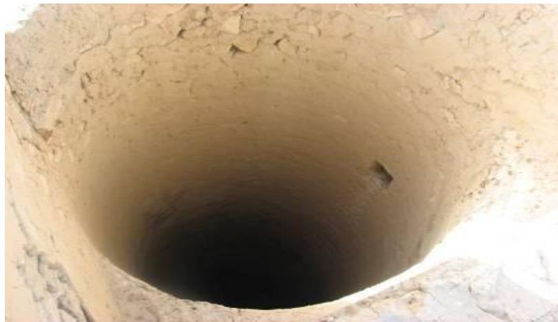
شکل ۲- نمایی از داخل چاه تغذیه ای و دریچه ورود آب به داخل چاه، دیواره از سنگ و ساروج
